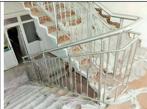
Перила с вертикальным заполнением для лестницы
